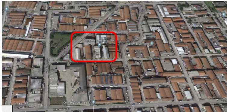
Figura 22 – Edifici costituenti lo stabilimento Settebello (con edifici E e G di recente acquisizione)
